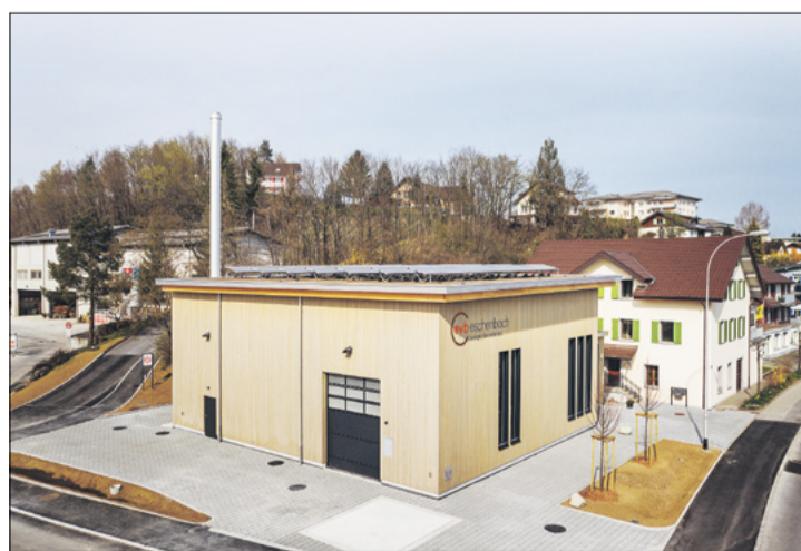
Die Holzenergiezentrale in Eschenbach LU wurde mit Schweizer Holz gebaut. Das Schnitzelsilo ist unterirdisch. (Bild zvg)
