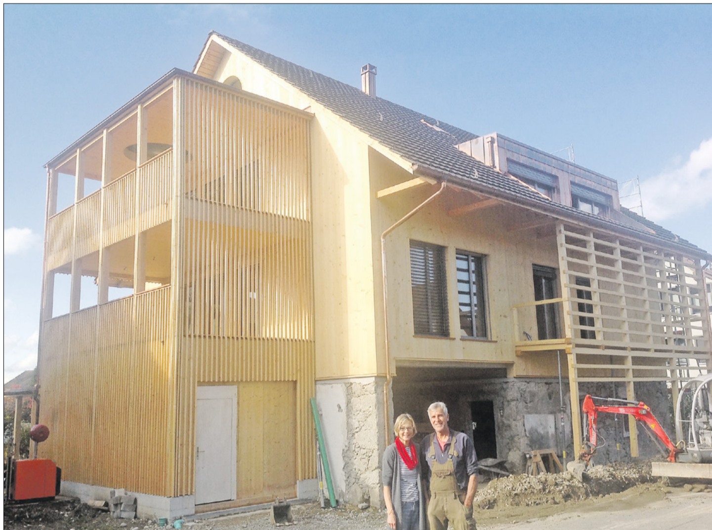
Willy und Annelies Huber vor ihrem Neubau mitten in Jonen. Das Wohnhaus wurde in Vollholz-Bauweise erstellt.
