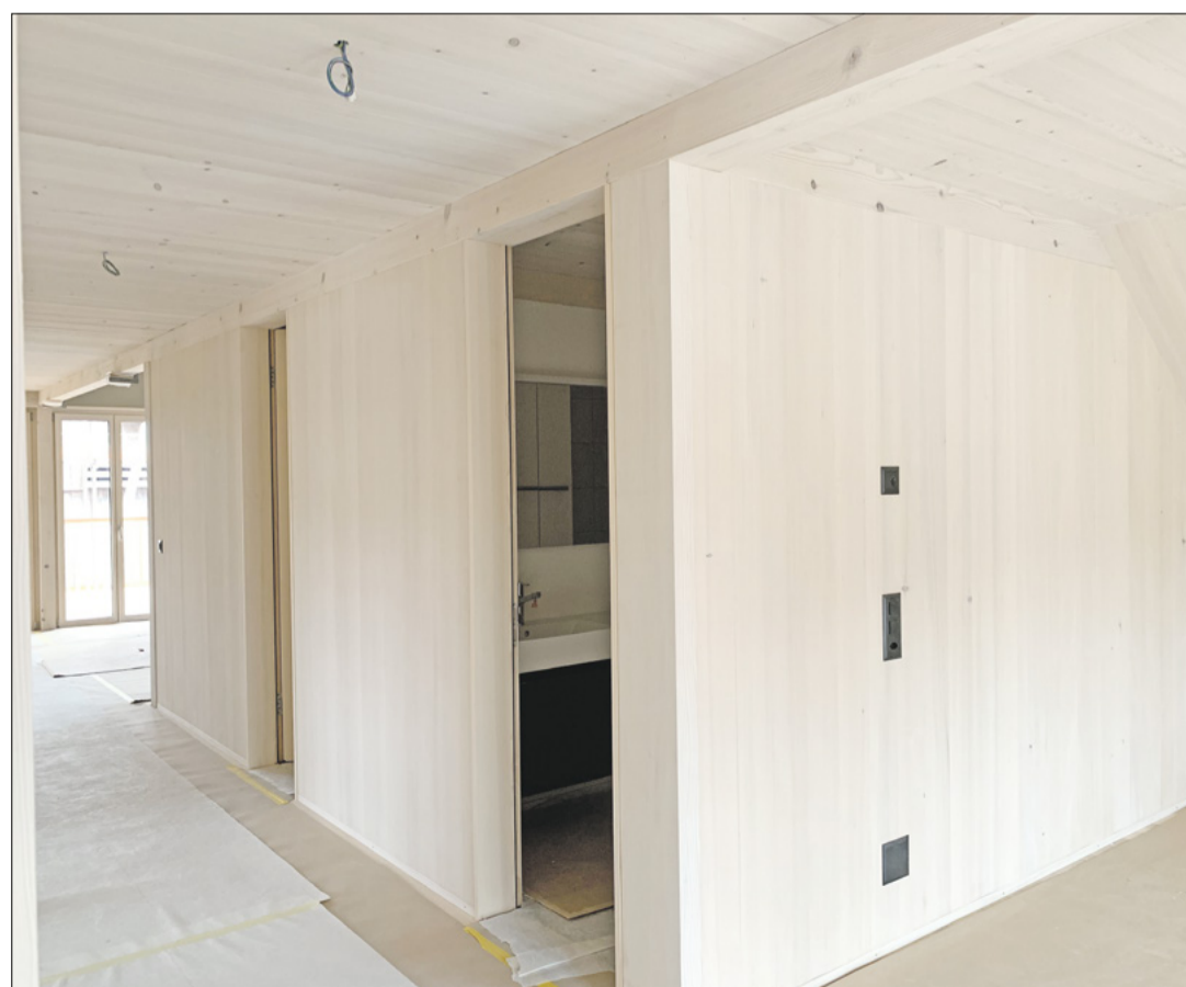
Blick in die Wohnung, noch im Rohbau. Die Holzwände und Decken sind geseift.
