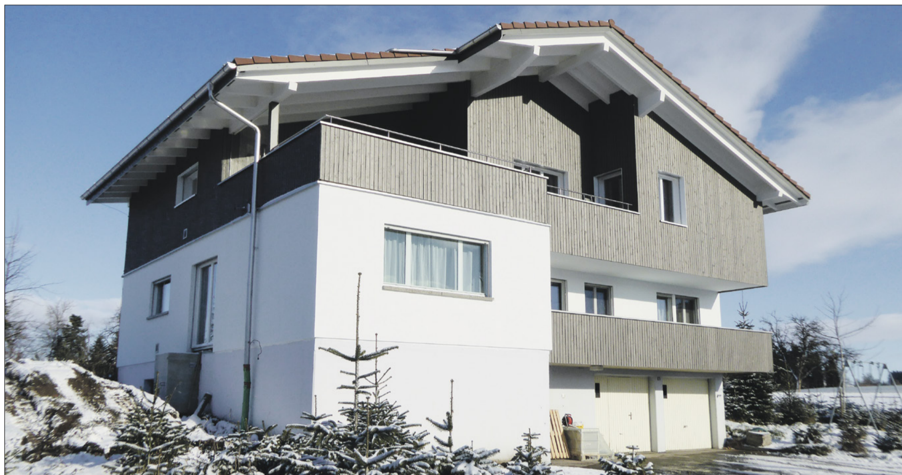
Der Ersatzneubau für ein Wohnhaus mit zwei Wohnungen. Viel Holz, aber nicht nur. Unterbau und gemauertes Treppenhaus (l.) wurden übernommen. (Bild Hubert Meier)
