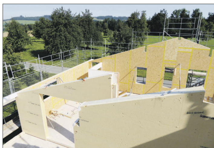
Denk den vorgefertigten Holzelementen konnte sehr speditiv gebaut werden. (Bild Hubert Meier)
