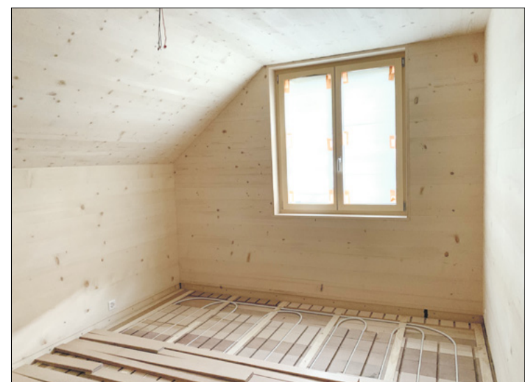
Massiver Bodenaufbau in Holz. Die Bodenheizung ist direkt in die ausgefrästen Buchenbretter eingelegt.
