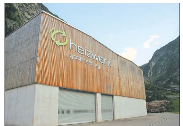
Das Holz-Heizwerk Gotthard in Göschenen versorgt Andermatt mit Wärme.
